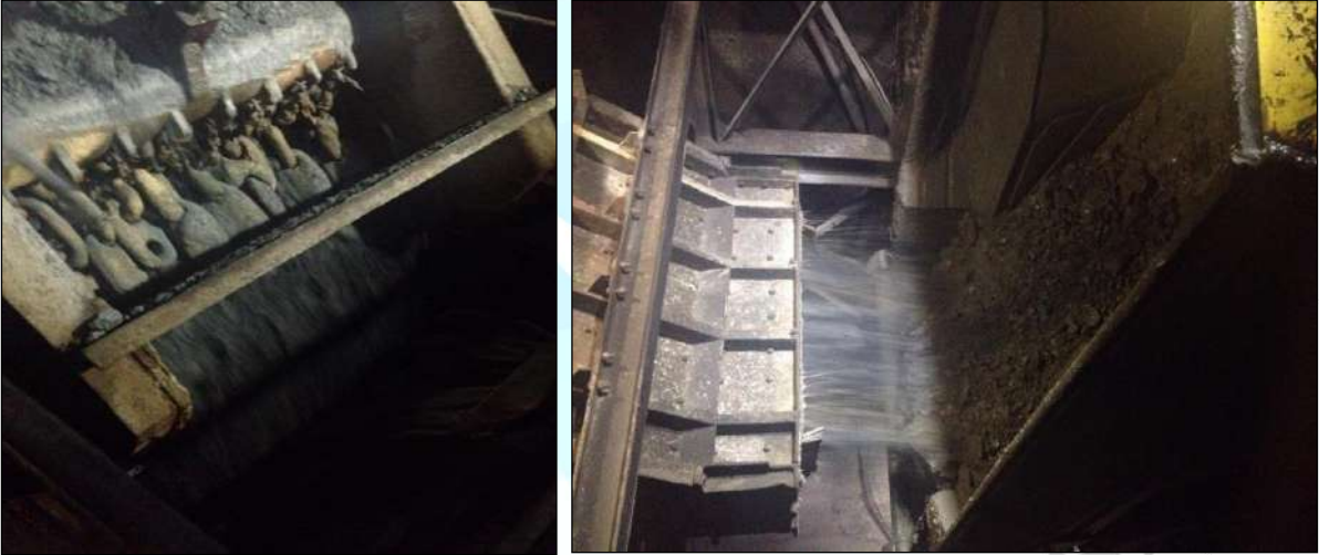
Görsel 1. Çimentolu pasa dolgunun pasanın bulunduğu kuyu ağzı ve enjeksiyon karışması
