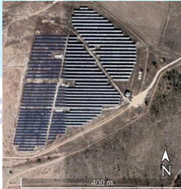
Görsel 1. KM Güneş Enerji Santrali
