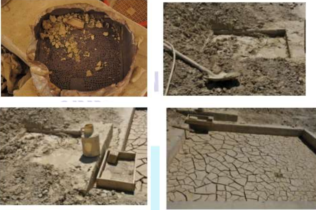
Şekil 2. Kelpuregan’da Çamur Hazırlama Süreci
