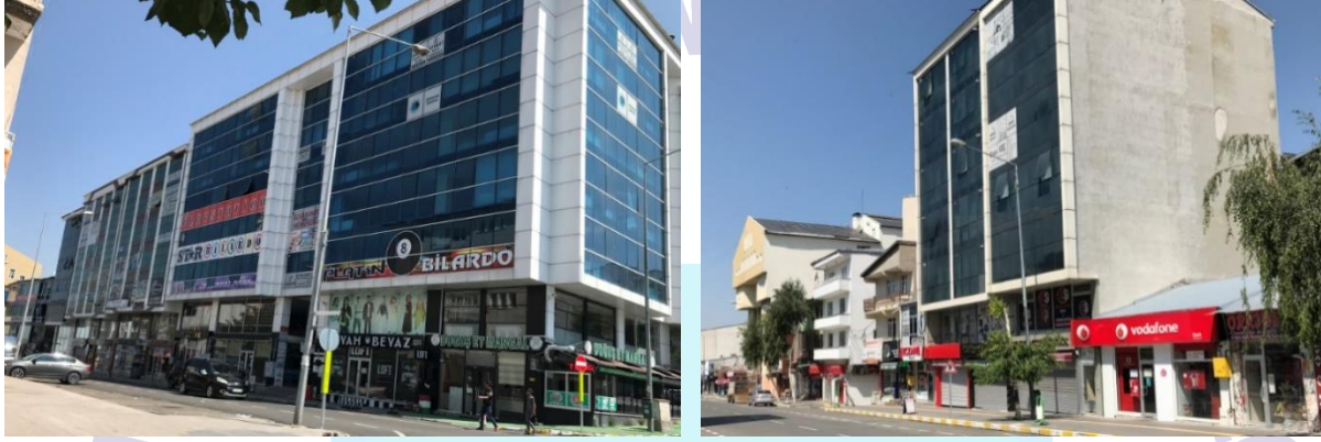
Görsel 6. Ardahan yapı stoğunun çarpışma etkisine sahip örnek yapılar.
